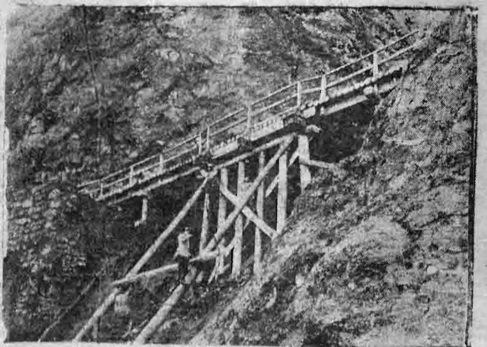
'Επιδιόρθωσις γεφύρας καταστραφείσης ὑπὸ τῶν Ρουμάνων.
