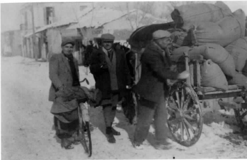
Γιδάς 18 Ιανουαρίου 1954. Στην παλιά αγορά "Σ. Σταθμός".
