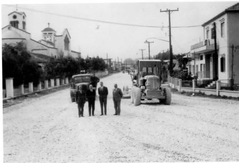
Οδός Εθνικής Αντίστασης 1965. Διακρίνεται από δεξιά: Ζώης Γεώργιος (τοπογράφος), Μπέρσος Βασίλειος (Δήμαρχος Αλεξάνδρειας), Δούμας Αθανάσιος (Γραμματέας του Δήμου), Μπαλτσής Κώστας στο βάθος καταβρέχει τον δρόμο για την προετοιμασία του ασφαλτοτάπητα.
