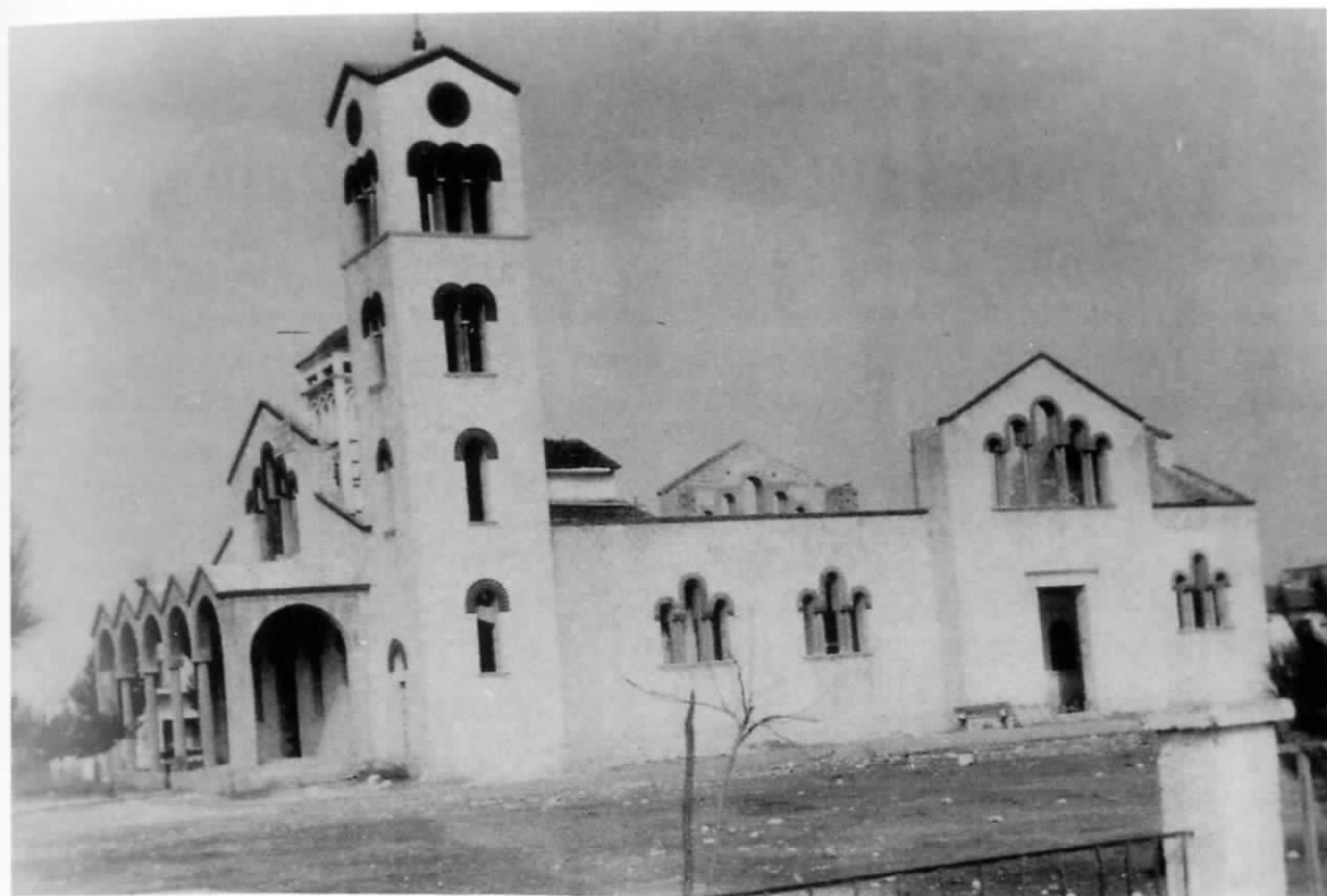
Η εκκλησία της Παναγίας στο στάδιο της κατασκευής.
