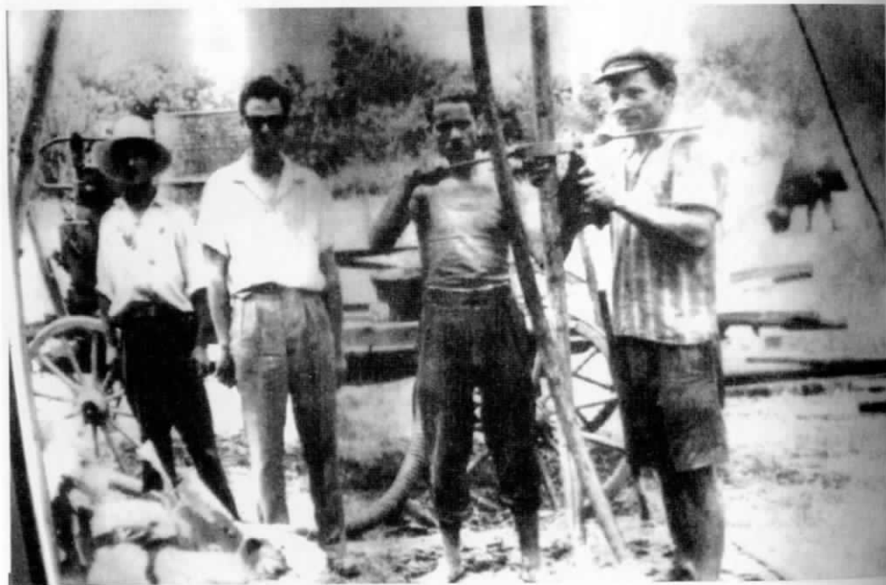
Συνεργείο γεώτρησης "επί το έργον".
