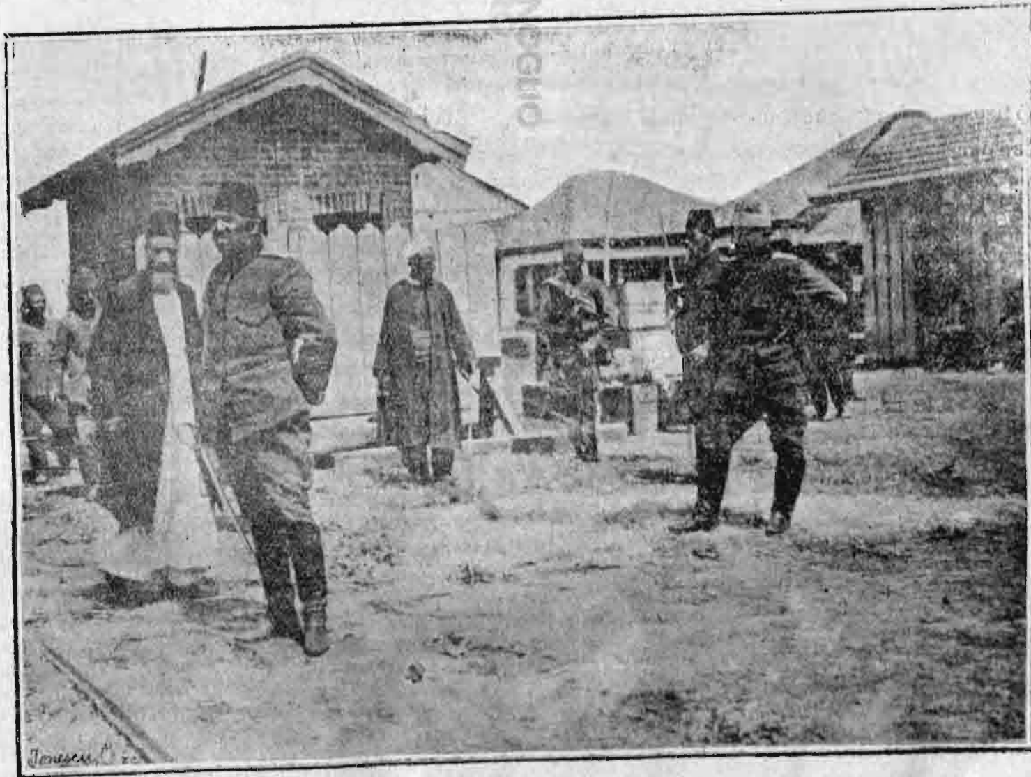
Βούλγαρος ἀρχισυμμορίτης, μετημφιεσμένος εἰς χότζαν, ἀρνεῖται νὰ δμολογήσῃ τὸ ὄνομά του καὶ καταδικάζεται εἰς ἀπαγχονισμόν.
