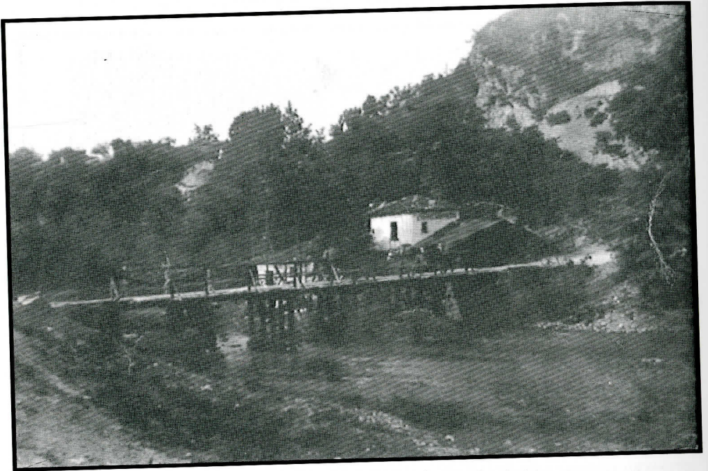
Η ξύλινη γέφυρα που αντικατέστησε την πέτρινη γέφυρα του Σταυρού μετά την πλημμύρα του 1935
