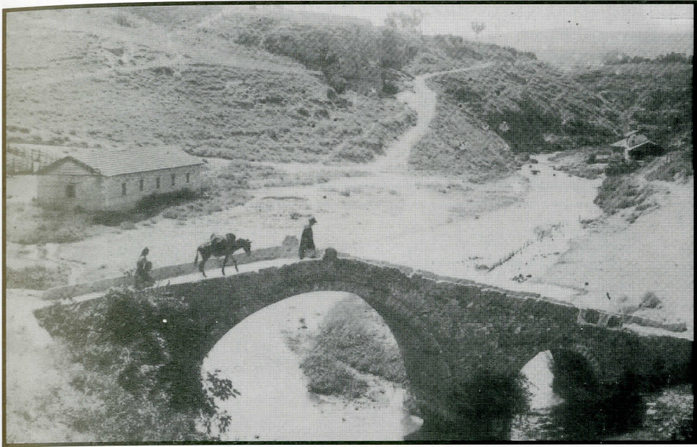
Η δίτοξη γέφυρα του Σταυρού. (Αρχείο Καλλιγά Γερ.)
