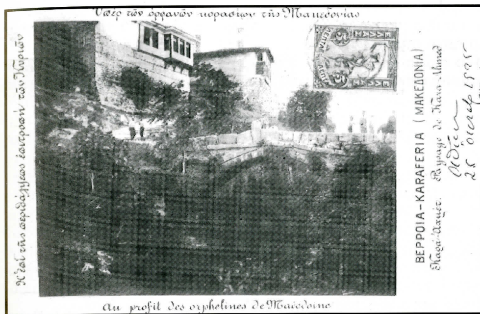
Η δίτοξη γέφυρα Καραχμέτ σε ευχετήρια κάρτα (Αρχεῖο Καλλιγὰ Γερ.)
