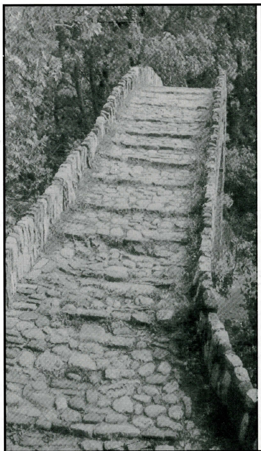
Το λιθόστρωτο οδόστρωμα (καλντερίμι) πέτρινης γέφυρας
