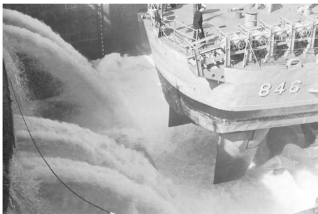
Το γέμισμα της δεξαμενής επισκευών
