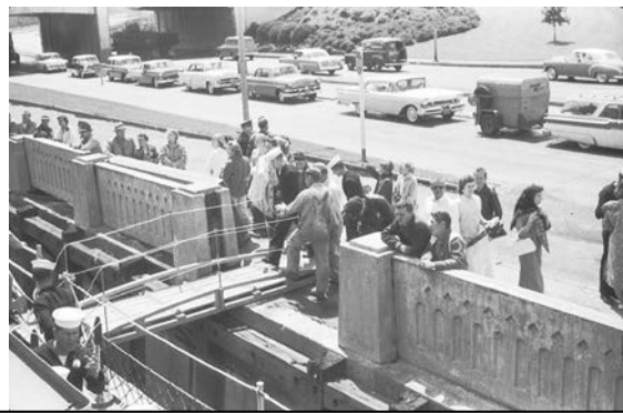
Η κινητή γέφυρα από την προκυμαία στο κατάστρωμα
