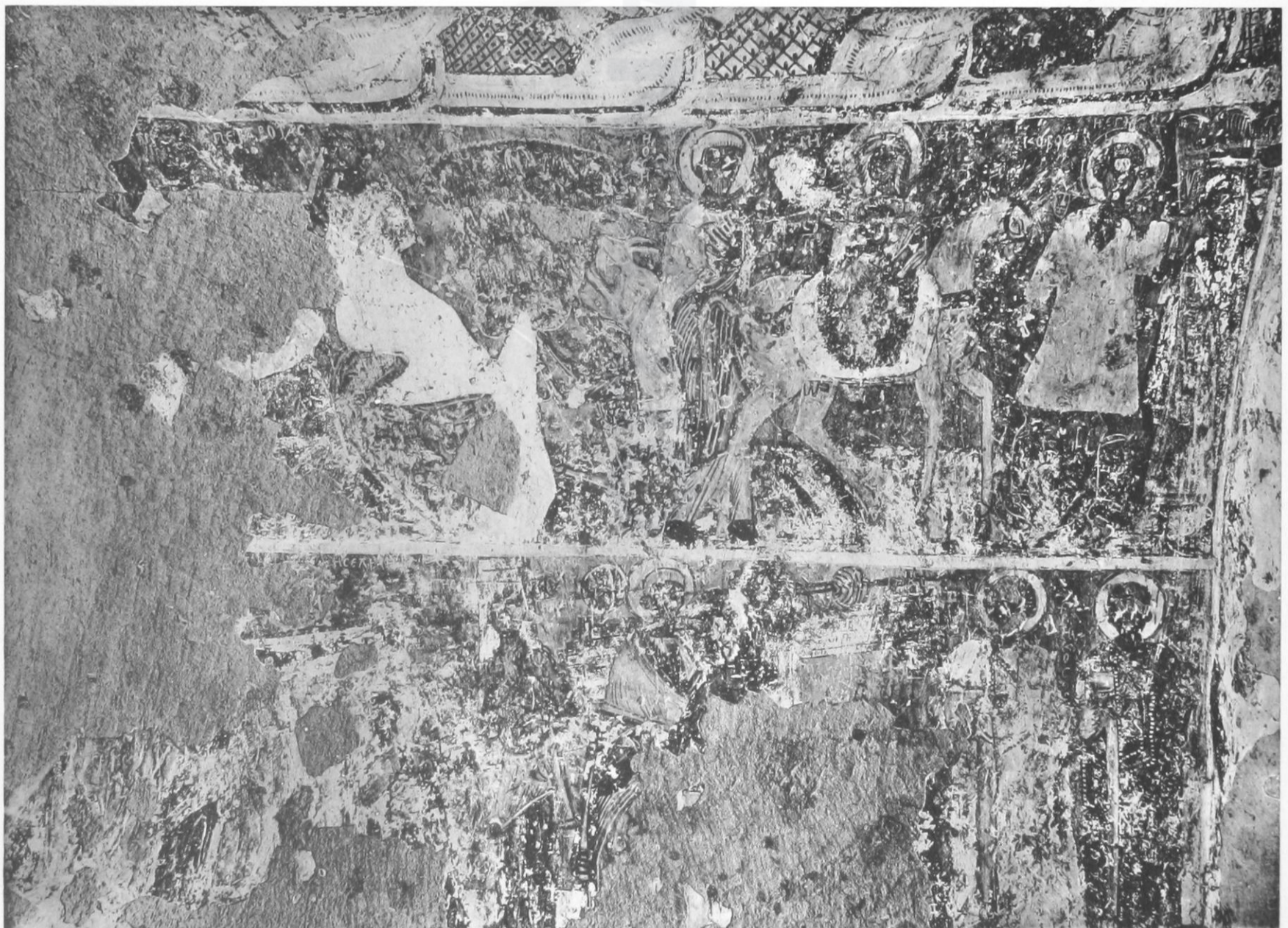
2. Côté nord de la voûte (partie droite).
