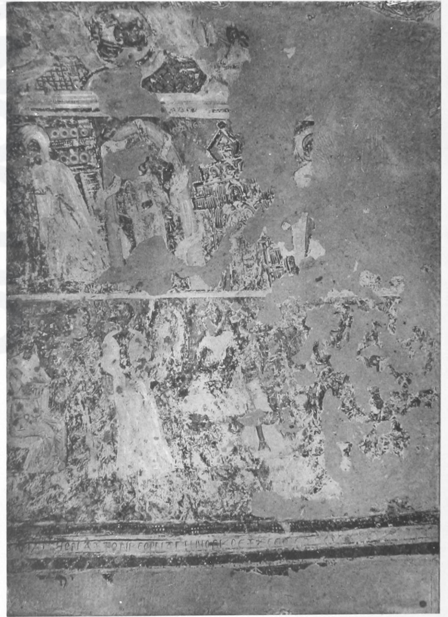
4. Côté sud de la voûte (partie droite).
