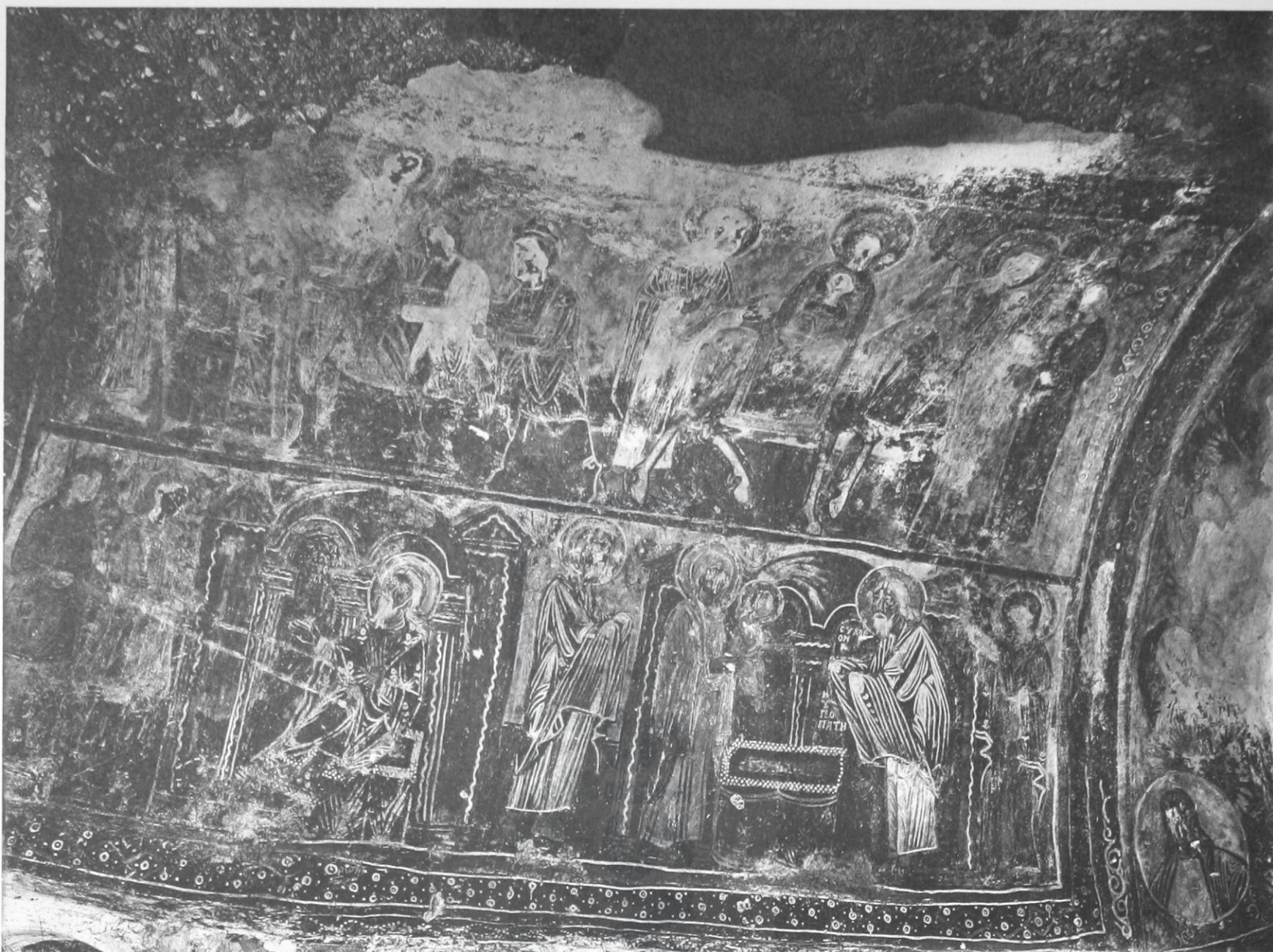
1. Voûte de la nef centrale (côté nord).
