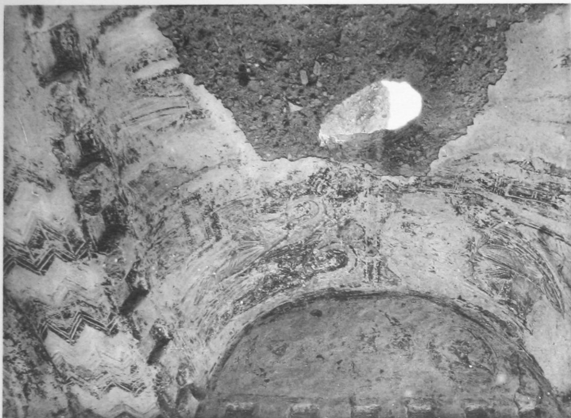
1. Chapelle III : voûte en berceau.
