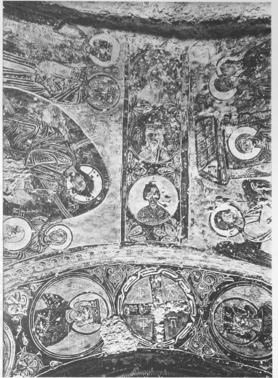
2. Voûte à la travée supérieure.
