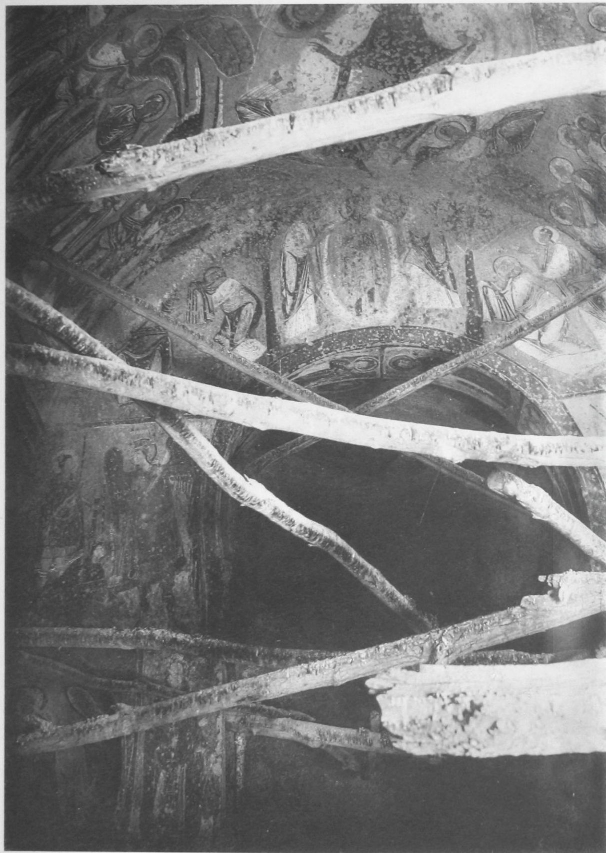
1. Vue d'ensemble : vers l'abside.
