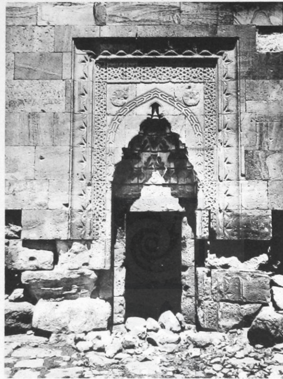
2. Une porte intérieure au Sare Khan.
