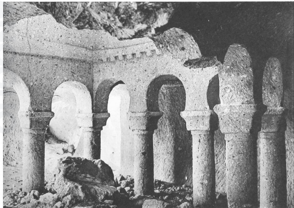
4. Église inférieure à Belli Kilissé : la nef.
