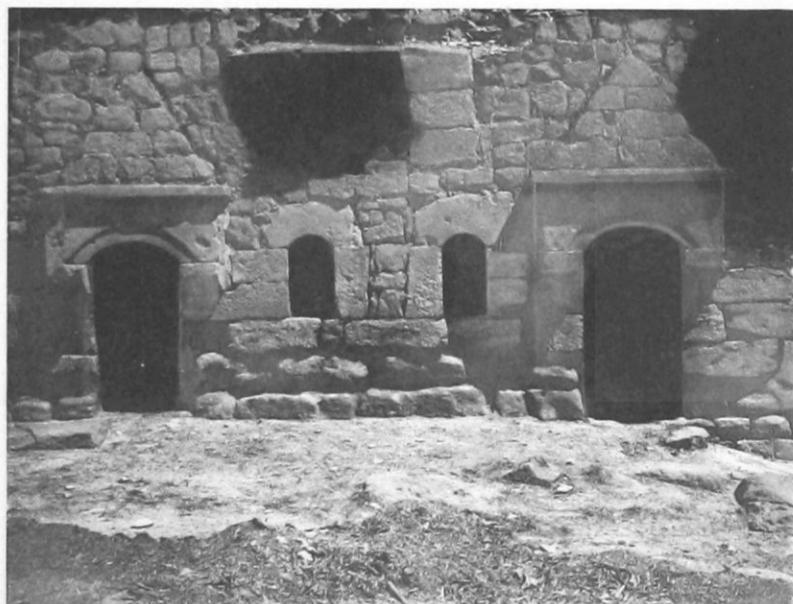
5. Khan d'Indjé Sou : foyers dans la cour.
