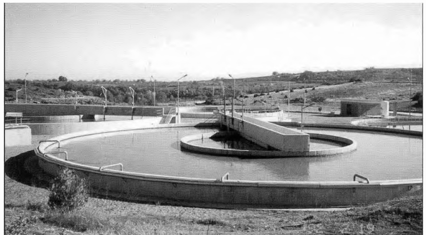
Οι εγκαταστάσεις του Βιολογικού Σταθμού Νάουσας
