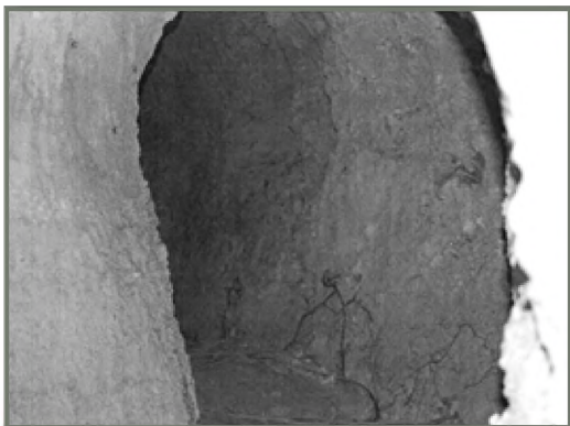
Είσοδος υπόγειας στοάς
