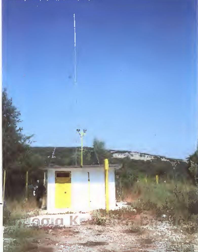
Τοπικός Σταθμός Πηγές Μαυρονερίου.
