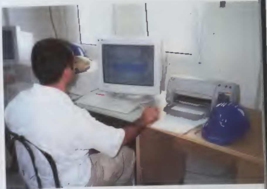
Τηλέλεγχος Τηλεχειρισμός ΔΕΥΑΒ στον κεντρικό σταθμό.
