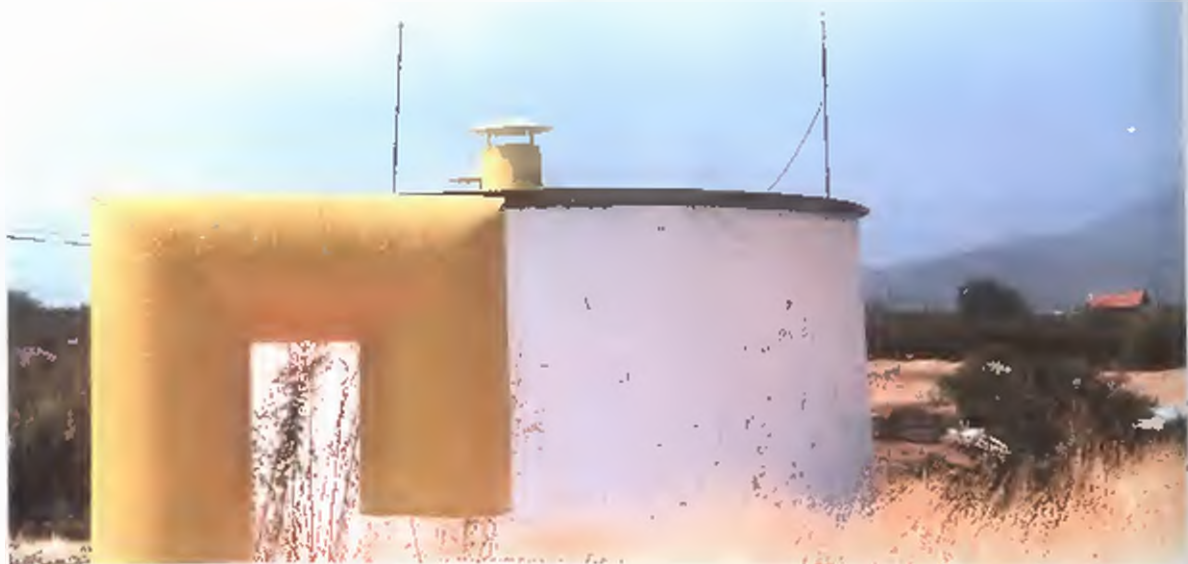
Τοπικός Σταθμός Δεξιμενίης 2Χ1700m 3
