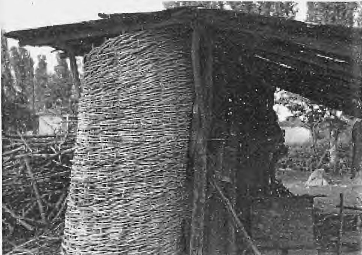
Κουτσερός κατασκευασμένος με πλοκό από βέργες ρακίτας.
