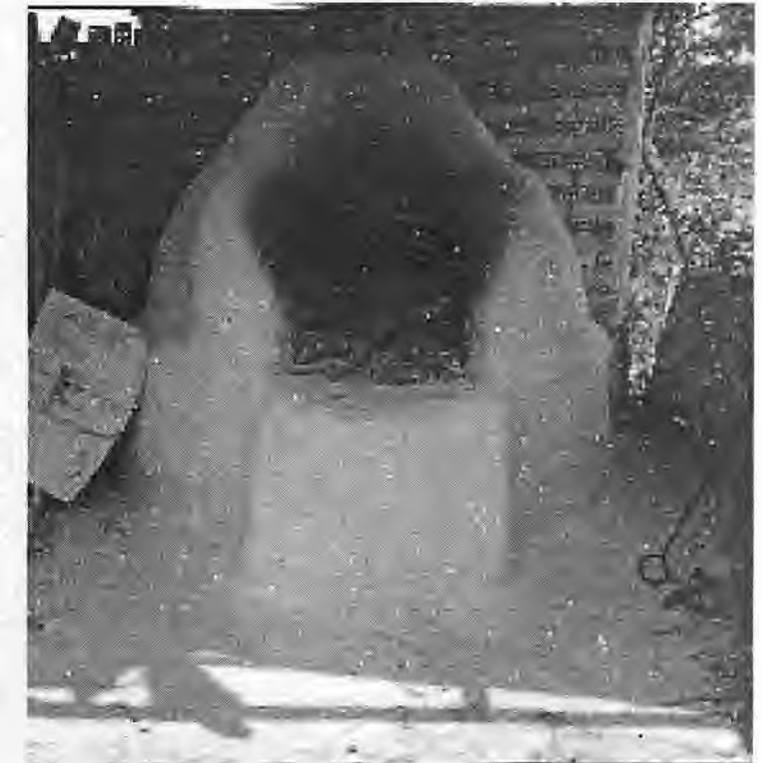
Κωνοειδούς σχήματος φούρνος, με βάση από πέτρα.
