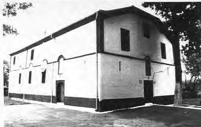
Βόρεια και δυτική όψη του ναού
