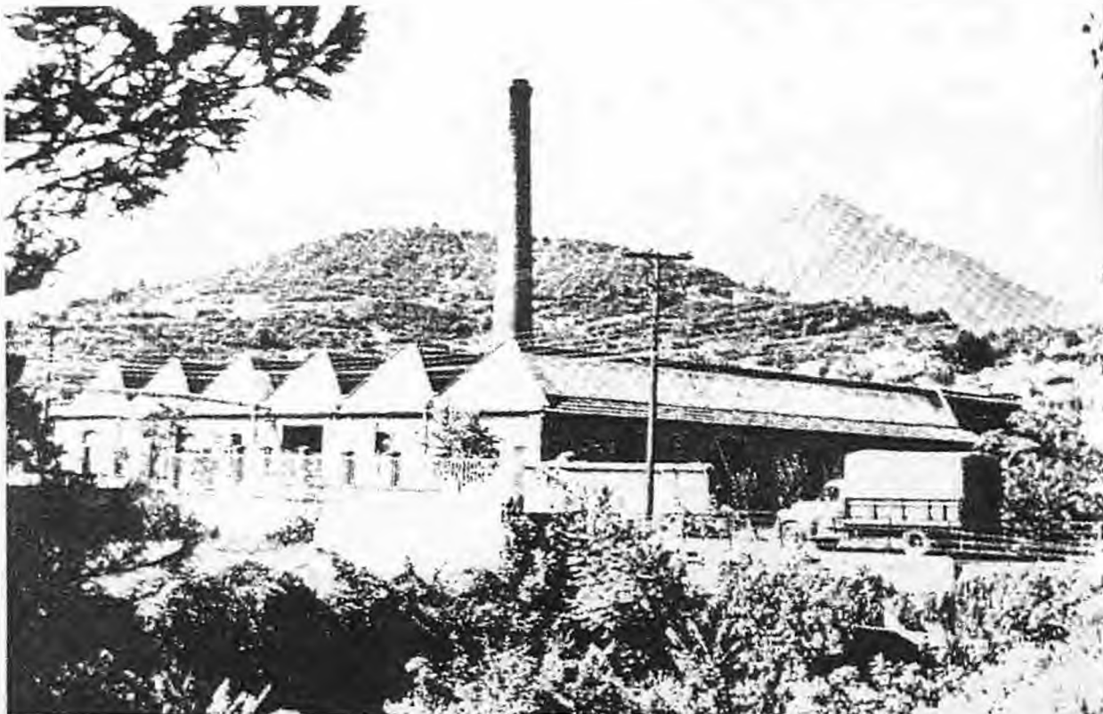
Το δυτικό τμήμα των εγκαταστάσεων με το γνωστό φουγάρο και τις υπόλοιπες εγκαταστάσεις πριν από την καταιστροφή τους
