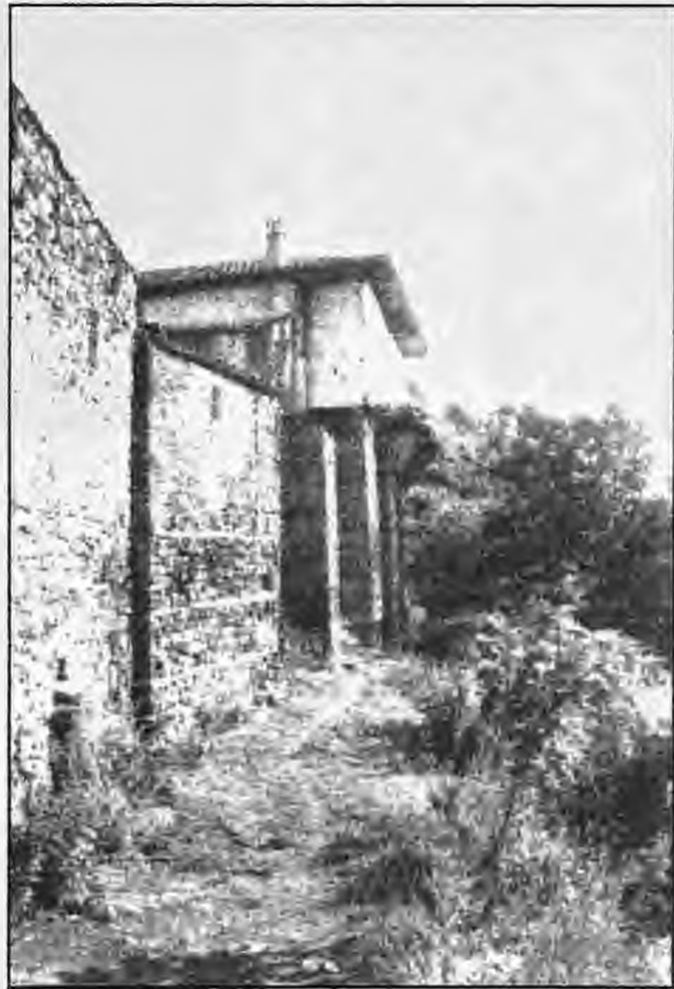
Εξωτερική όψη της Μονής
