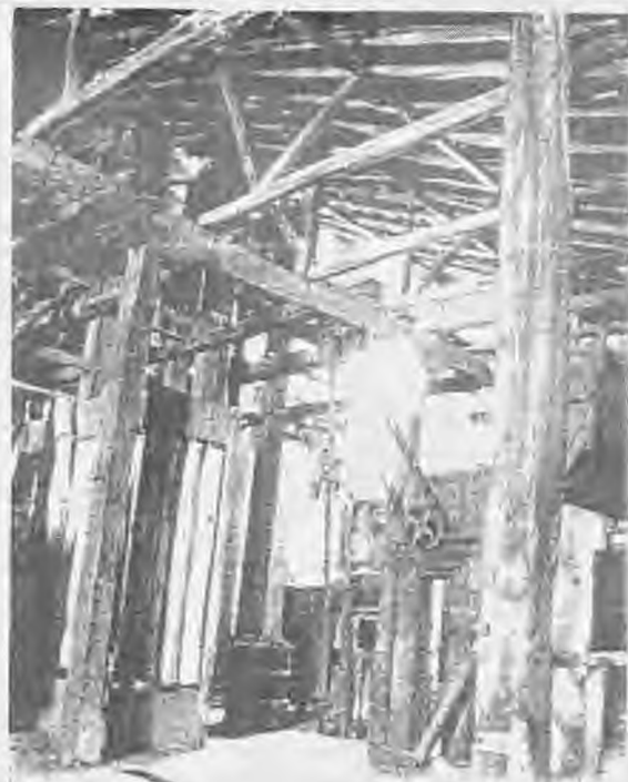
Αποψη από το δεύτερο όροφο του κυλινδρομύλου Μιθθαίου, όπου διακρίνονται οι σπλιλέκτες σπίνης, ο διαλογέας και τα φυγοκεντρικά κύματα (Φωτογραφία Είσης Μαυρουδής) Από μελέτη ο κυλινδρομύλος Μιθθαίου στη Νάουσα. Έκδοση Πολιτιστικό Ίδρυμα ΕΤΒΑ Αθήνα 1992)
