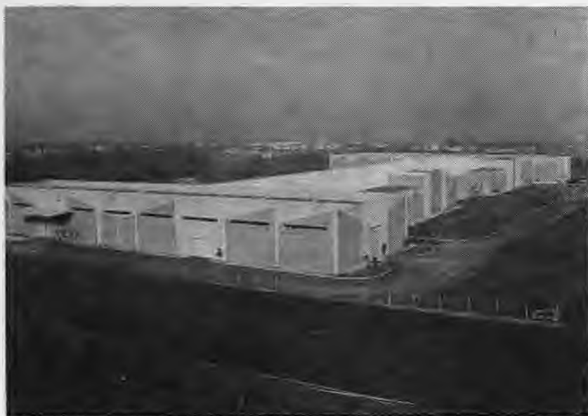
Οι νέες εγκαταστάσεις της ΒΑΡΒΑΡΕΣΟΣ Α.Ε. στο Στενίμαχο
