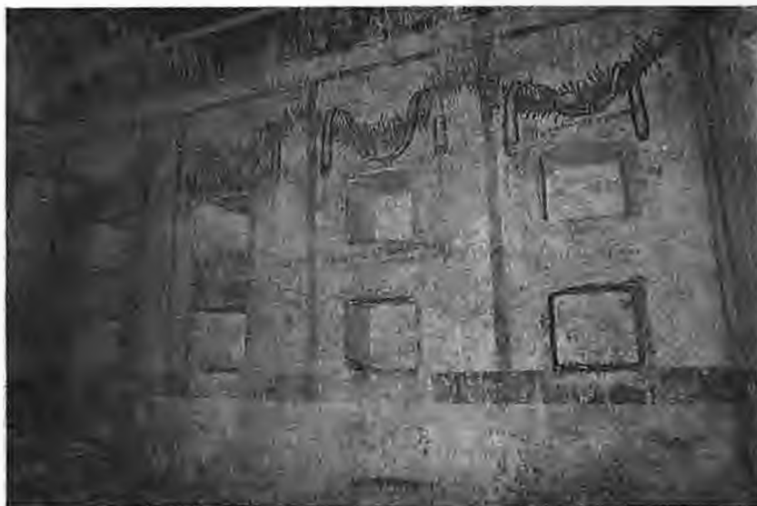
Φωτ. 4. Ο ανατολικός τοίχος, με τις κόγχες των απογόνων του Καλλικλή
