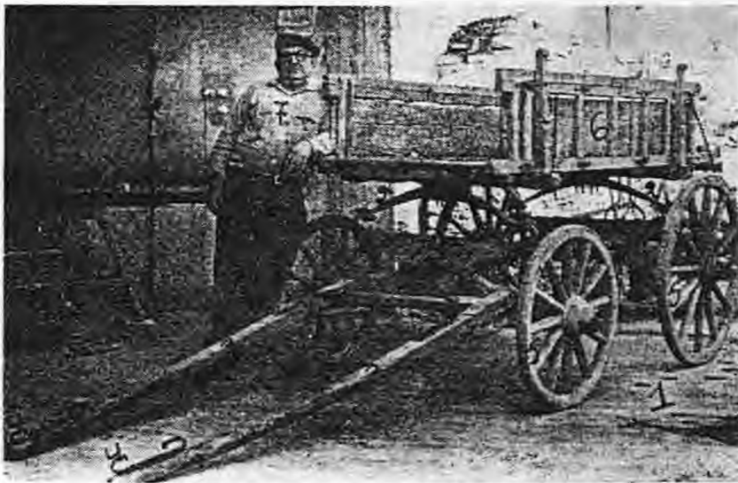
Φοιτ. 8. Κορουποισίου Πέτκου Τρύφανι μαθητή του Ναουσοίου Αντώνη Τσιλιάνη που πήγειν στα 1924 στον Αγρα Εδιόσας. 1. Η σουύστα ή Μπρίτσκα 2. Σουύστες 3. Κόλια 4. Γάντζοι 5. Ρόδες 6. Κάρα
