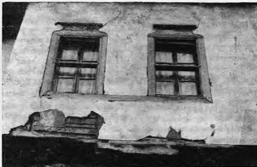
Λεπτομέρεια από την εξωτερική όψη. Εντίσωση κάνει η κομψή γραμμή των παραθύρων. Διακρίνονται επάνω τα φανάτια που έκλειναν κατά τη διάρκεια της νύχτας.
