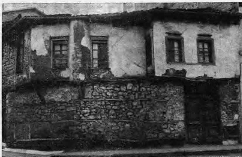
Εξωτερική άποψη του σπιτιού με το χαρακτηριστικό ημικυκλικό τζακι και τους τσατμάδες.
