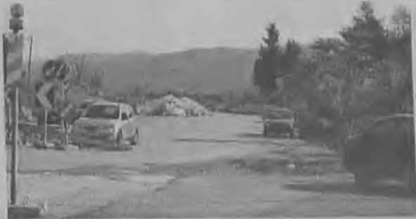
Το τμήμα της εισόδου της Δυτικής πλευράς της πόλης, στο οποίο ξεκινούν οι εργασίες αποκατάστασης, από την Εταιρεία ΑΚΤΩΡ Α.Ε. (ένθετη και κάτω φωτο).
