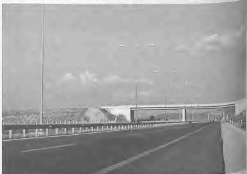
έτους, ενώ αμέσως μετά στην ευρύτερη περιοχή της Δυτικής Μακεδονίας προγραμματίζεται η κατασκευή Χώρου Στάθμευσης Αυτοκινήτων στον Ταξιότοπο και Σταθμός Εξυπηρέτησης Αυτοκινήτων στη Σιάτιστα Γρεβενών.
