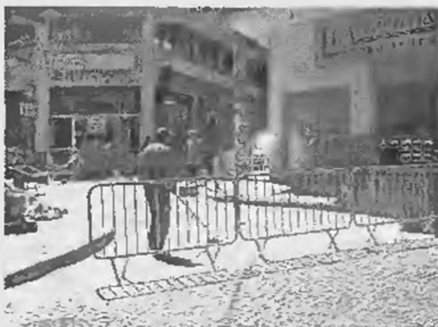
Ολοκληρώνονται εντός των ημερών τα έργα στην οδό Αντωνίου Καμάρα, όπου το μόνο που έμεινε η τοποθέτηση του πλακόστρωτου...
