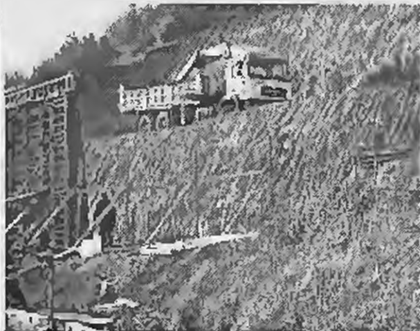
Η παρακαμπτήριος, η οποία κατασκευάζεται αυτή τη στιγμή και θα χρησιμοποιηθεί αργότερα για την πρόσβαση των πολιτών, στο υπό κατασκευή Δικαστικό Μέγαρο.
