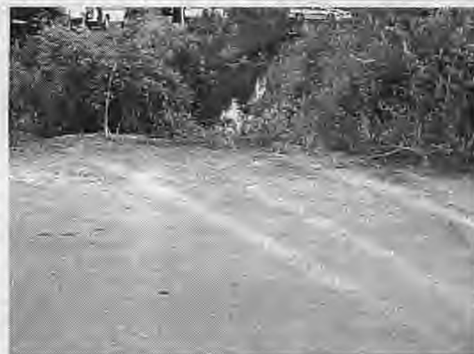
Το σημείο του τραγικού δυστυχήματος. Στο οδόστρωμα φαίνεται τα ίχνη από το φρενάρημα του αυτοκινήτου πριν πέσει στο αρδευτικό κανάλι.
