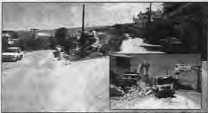
Ξεκίνησαν μέσα στην εβδομάδα τα έργα στην οδό Πισρίων. Ενδεικτικές οι φωτογραφίες με το γκρέιμ-σμά του σπιτιού και το δ-νοήμα του δρόμου.
