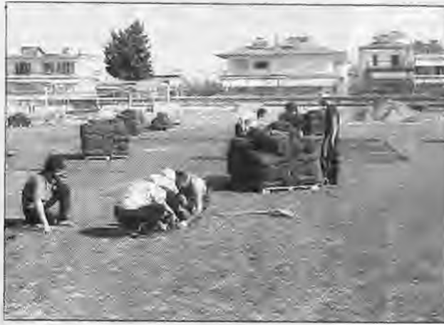
Ξεκίνησαν οι εργασίες κατασκευής του χορτοτάπητα στο Εθνικό στάδιο Βέροιας. Οι υπάλληλοι πρώτα ξήλωσαν τον κατεστραμμένο και στη συνέχεια τοποθετούν τον καινούριο. Ο νέος χορτοτάπητας ήρθε από τη Λάρισα.
