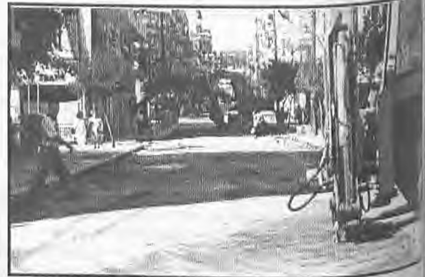
Με εντατικούς ρυθμούς συνεχίζονται τα έργα στην οδό Παρ πόλεως, η οποία αναμένεται να μεταμορφωθεί.
