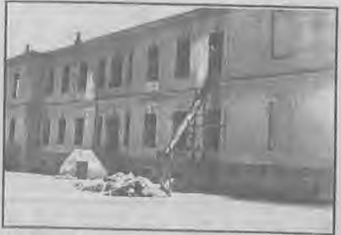
Με γοργό ρυθμό συνεχίζονται οι εργασίες για την κατασκευή του Δημαρχείου Βέροιας.
