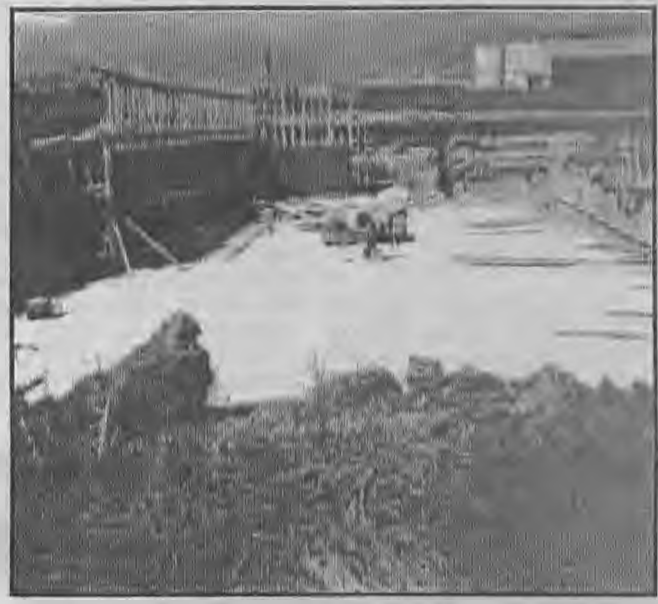
Η φωτογραφία είναι από τις εγκαταστάσεις του υπο κατασκευών συστήματος βιολογικού καθαρισμού της ΚΟΝ-VERI.
