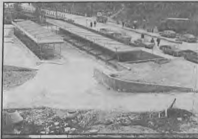
Τα στέγαστρα που έχουν κατασκευασθεί στην γέφυρα του Τριποτάμου όπου γίνεται σήμερα η λαϊκή αγορά.
