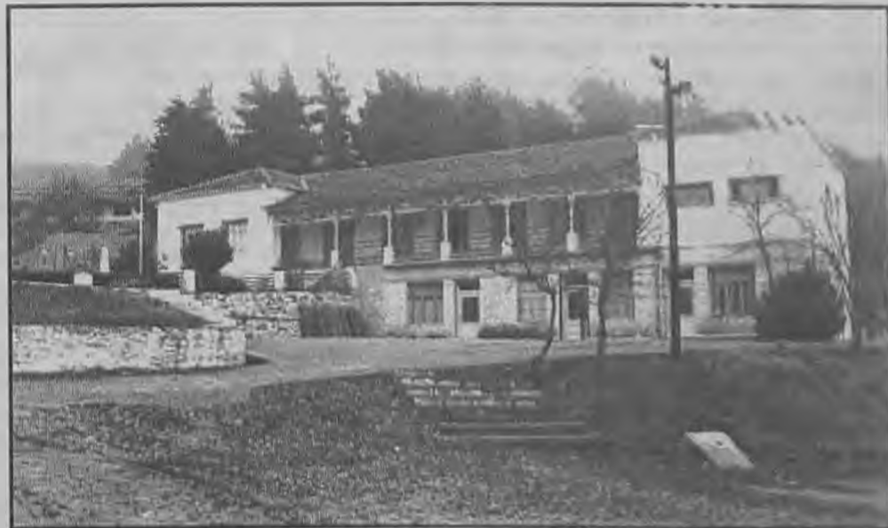
Το κεντρικό κτίριο της Παιδούπολης στο οποίο έγιναν σημαντικές εργασίες συντήρησης, ενώ στους διαρρυθμισμένους χώρους του τοποθετήθηκαν εκατό κρεβάτια για φιλοξενία.
