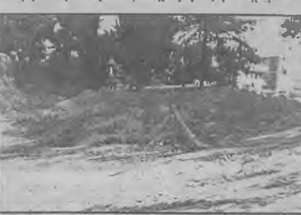
Θα συνεχιστεί η αποχωμάτωση του "Βράχου" στα νεκροταφεία (φωτο), οπιοσώστε να δημιουργηθεί χώρος πάρκιγκ.
