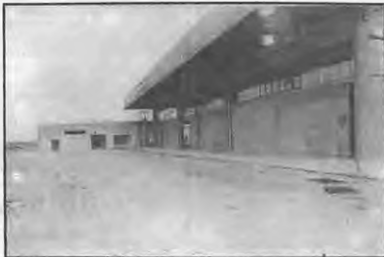
Οι εγκαταλειμμένες ημιτελείς εγκαταστάσεις της Περιφερειακής Αγοράς Κουλούρας
