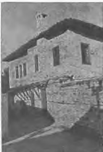
Το παραδοσιακό σπίτι της Ταμπάκη Φραζερικής στη Μπαρμπάτου που αναστηλώθηκε και που πήρε το Α' βραβείο στον αρχιτ. διαγωνισμό του Υ.Χ.Ο.Π.
