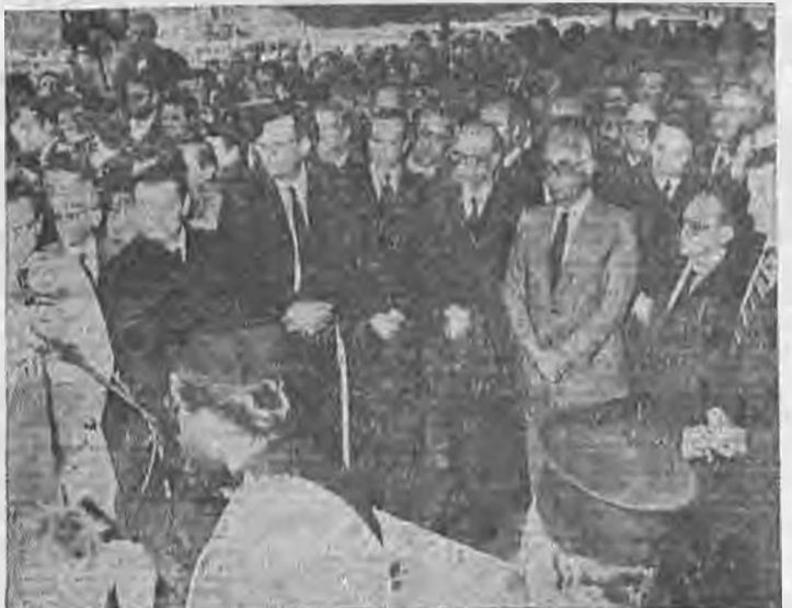
Στιγμιότυπο από τήν τελετή θεμελιώσεως των υδροηλεκτρικών έργων Σαρκιάς και Ασομάτων
