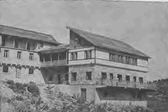
Το δημοφές καταφύγιο του Ορειβατικού Βερούας που έγινε στο Σέλι θα καλύψει πλήρως τις ανάγκες του συλλόγου και των αθλητών του. Στη φωτογραφία μας άποψη του καταφυγίου στο οποίο δόθηκε έπιτυχώς η παλιή Βεροιώτικη αρχιτεκτονική.
