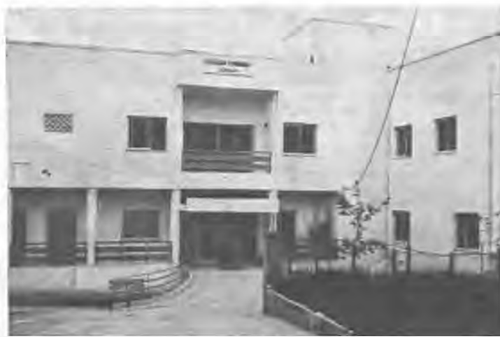
Τό νεόδμητον κτίριον του Γηροκομείου.
