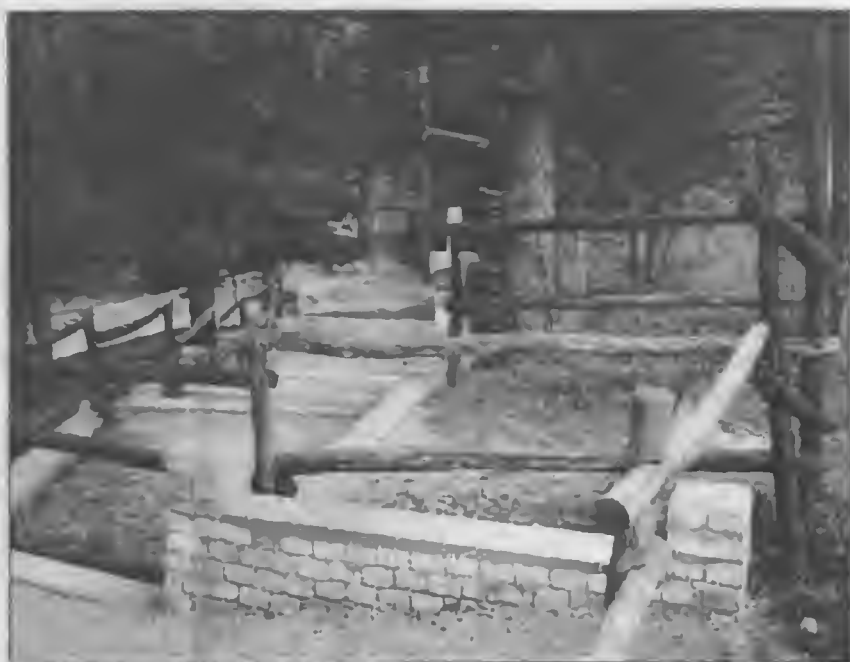
Ο διάδρομος WC πλήρως ανακατασκευασμένος
