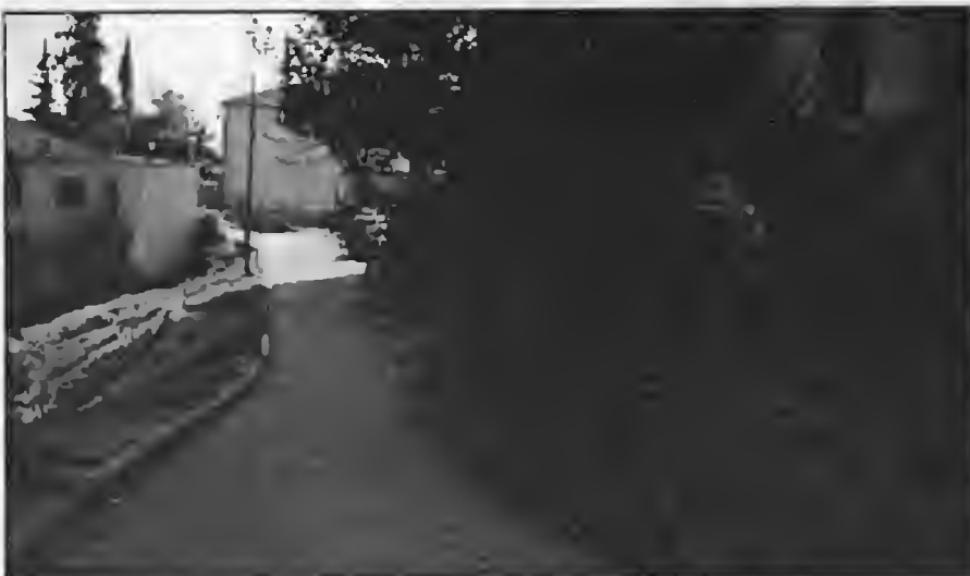
Ο δρόμος της οδού Ρόδων, τον οποίο καθημερινά διέρχονται αυτοκίνητα, λόγω της έλλειψης προστατευτικής μπάρας μεταξύ Τρεμπεσίνας και Ρόδων
