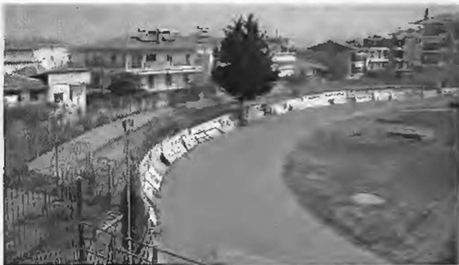
Κατασκευή κερκίδας στην βορειοανατολική πλευρά του γηπέδου (πέταλο στη θύρα 6) θα κατασκευαστεί άμεσα.
