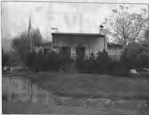
Το κτίριο είναι τα αποδυτήρια των ομάδων και των διαιτητών. Ε- να κτίριο το οποίο δίνει μια άλλη μορφή στο μικρό γήπεδο του Αγ. Νικολάου.
