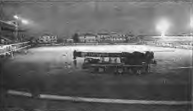
Εργολάγοι θύμιζε το Εθνικό στάδιο Βέροιας την προηγούμενη εβδομάδα, προκειμένου να στηθεί ο ηλεκτροφωτισμός.
