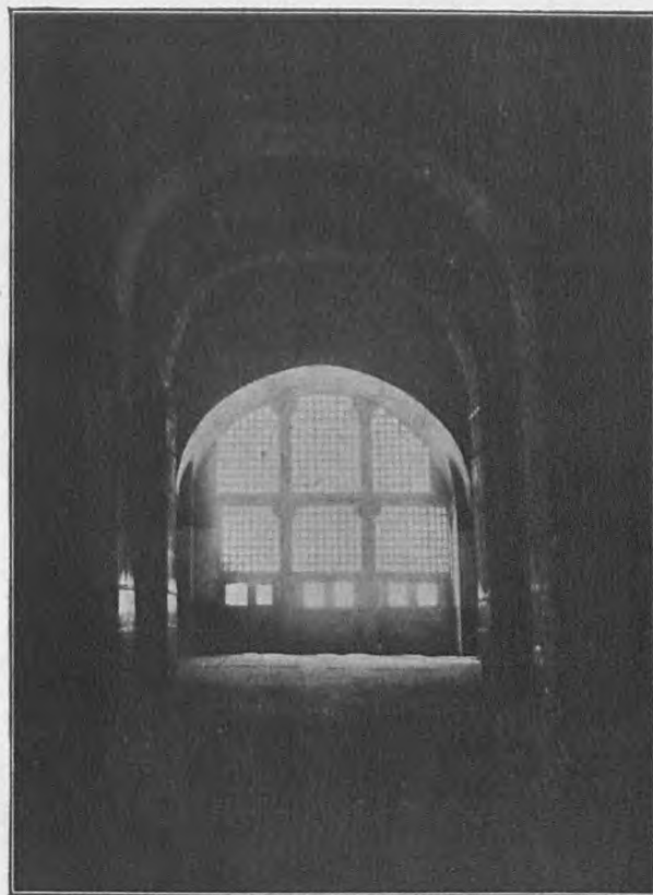
Σχ. 350. Ἡ ἐκ σεισμῶν παραμόρφωσις τοῦ βορειοανατολικοῦ πεσσοῦ, καὶ τῶν τόξων τῶν συνδεόντων αὐτὸν τῷ παραπησίῳ.
