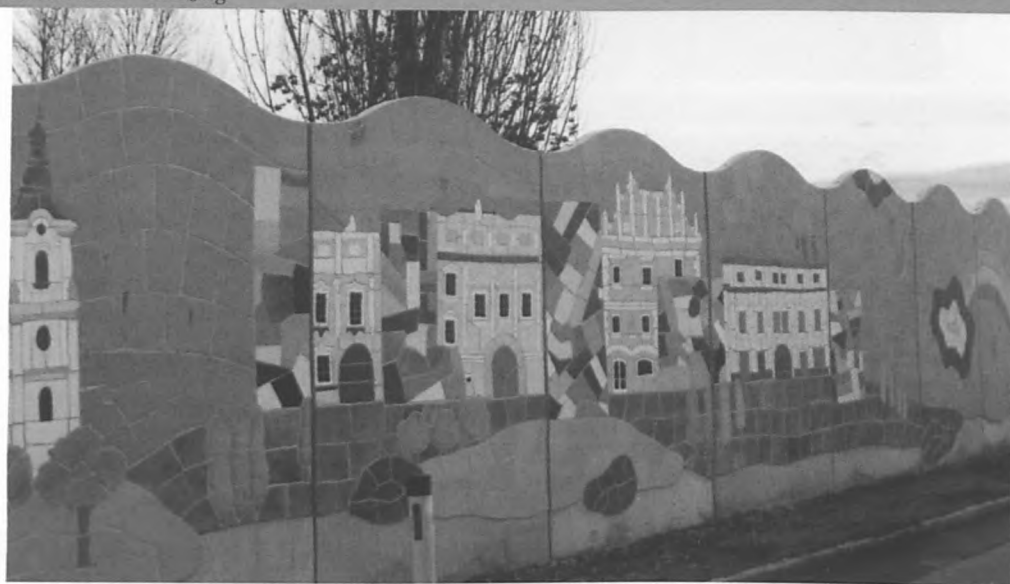
Schallschutzwand in Langenlois
