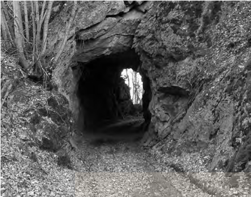
Σήραγγα της πρώην σιδηροδρομικής γραμμής σήμερα (φωτό: Αν. Καραμπαιζός)
