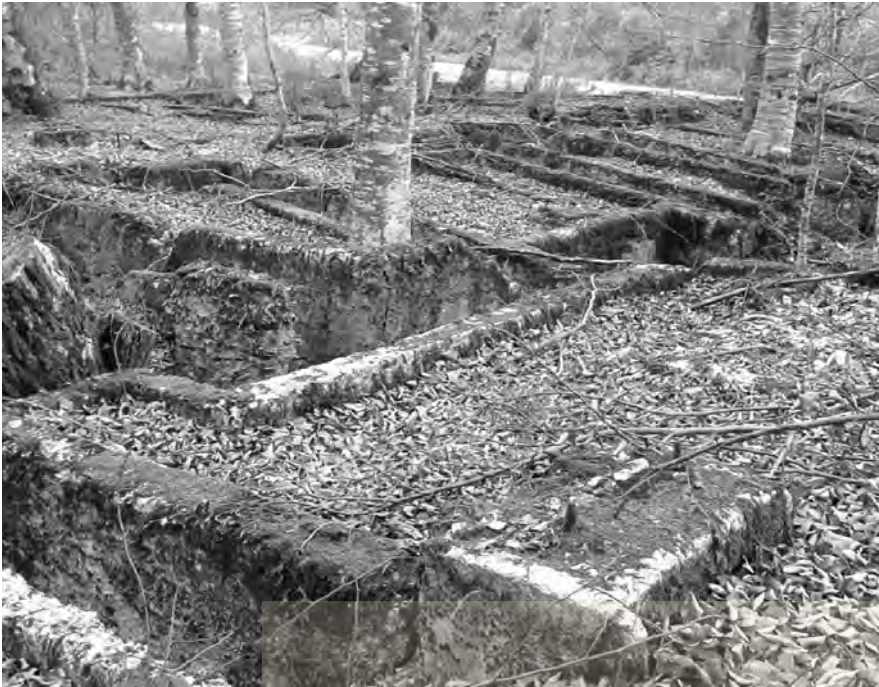
Ερείπια των εγκαταστάσεων του εργοστασίου στο «Γκουρνόσοβο» (φωτό: Αν. Καραμπαιζός)
