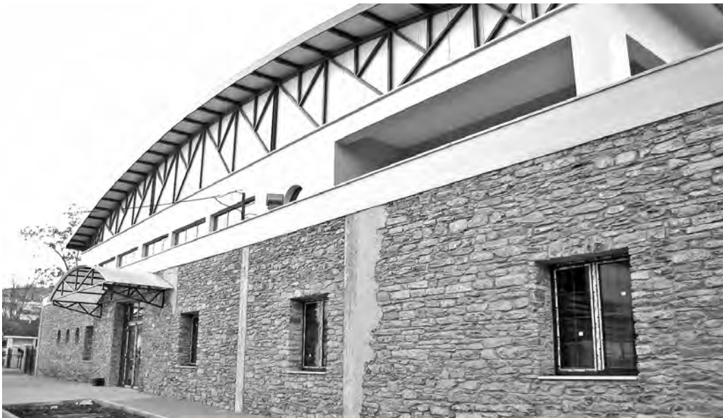
Το υπό αποπεράτωση Κέντρο Μελέτης και Τεκμηρίωσης Βιομηχανικής Κληρονομιάς
