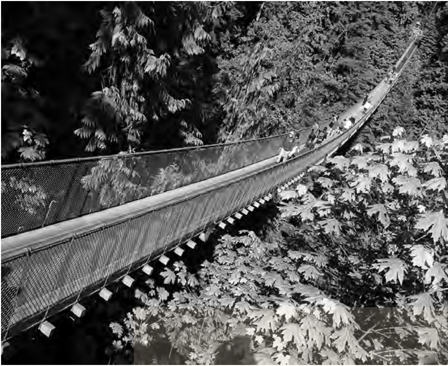
Η κρεμαστή γέφυρα στον ποταμό Capilano στο Βανκούβερ του Καναδά
