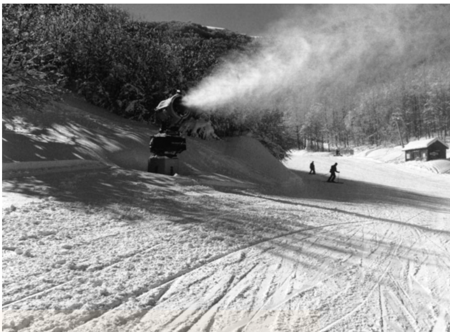
Οι εγκαταστάσεις τεχνητής χιόνωσης στα 3-5 Πηγάδια, μοναδικές στην Ελλάδα
