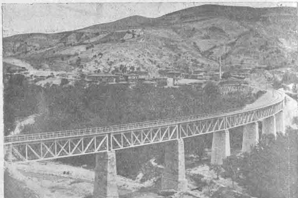
Viaduc de Pekdemir de 7 travées
