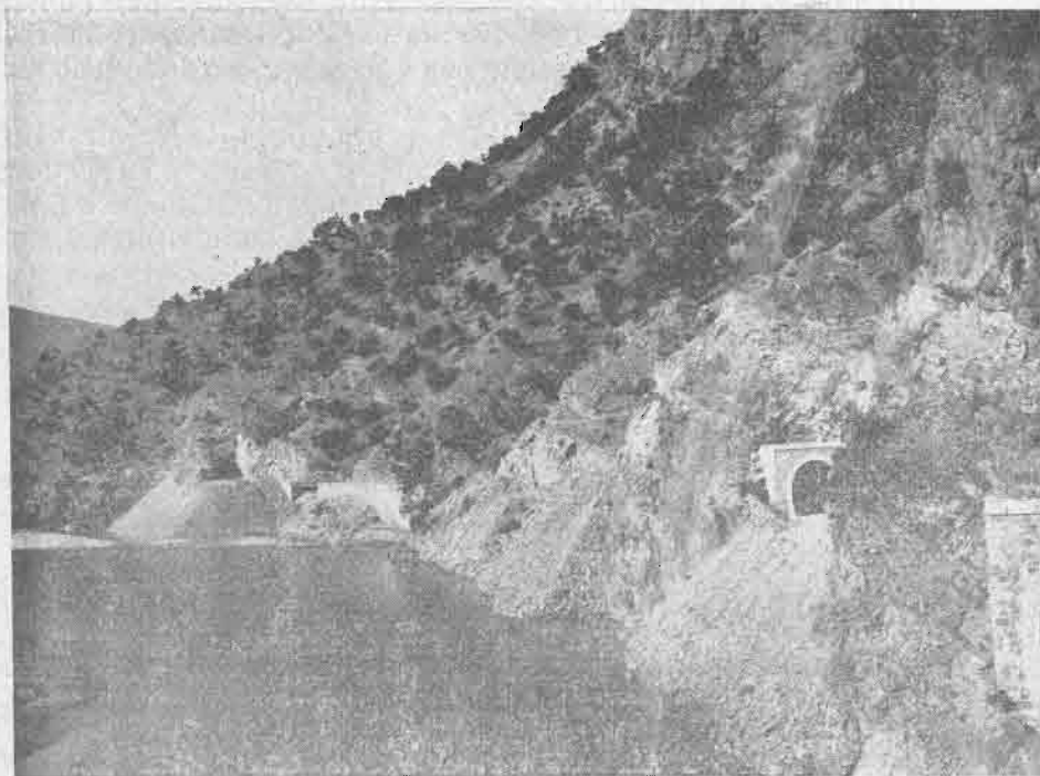
Vue du Tunnel dans le Défilé du Karassou au kilom. 275
