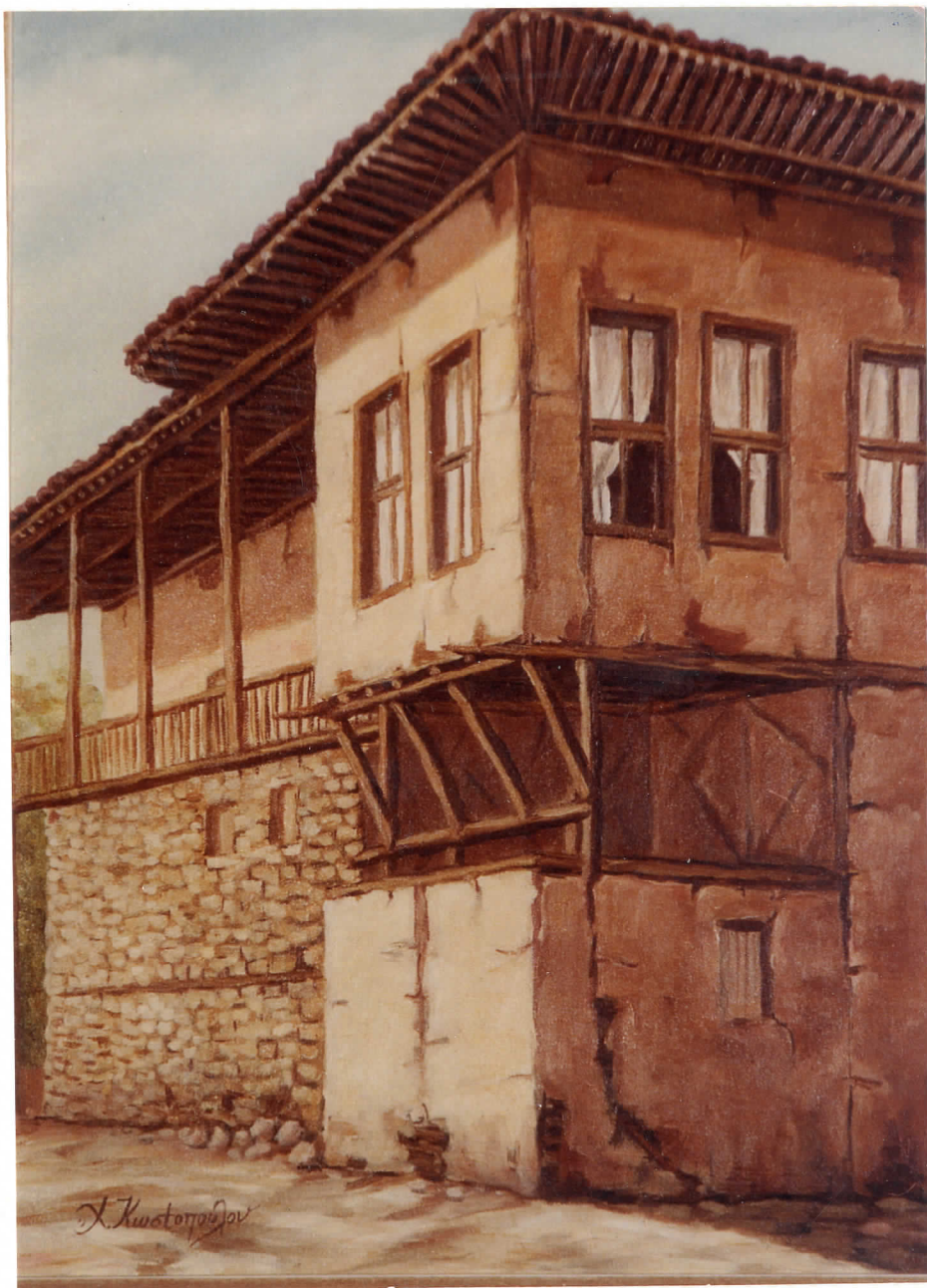
οδός 16ης Οκτωβρίου Κατεδαφίστην το 1961-62 και επί θέση επιρρυθμίστην το Γυμνάσιο Αρρέων
