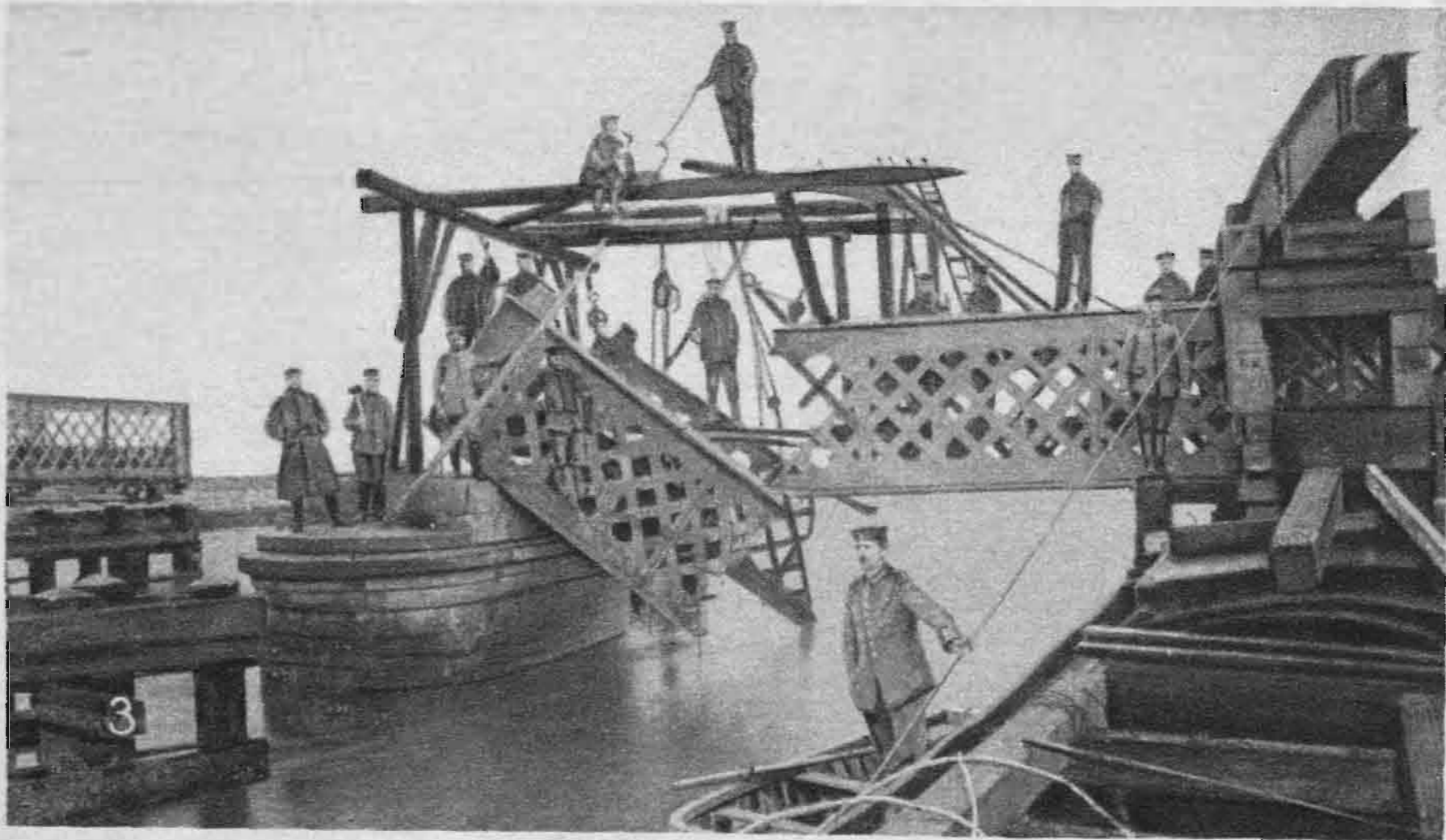
Wiederaufbau einer von den Belgiern zerstörten Brücke durch deutsche Pioniere.
