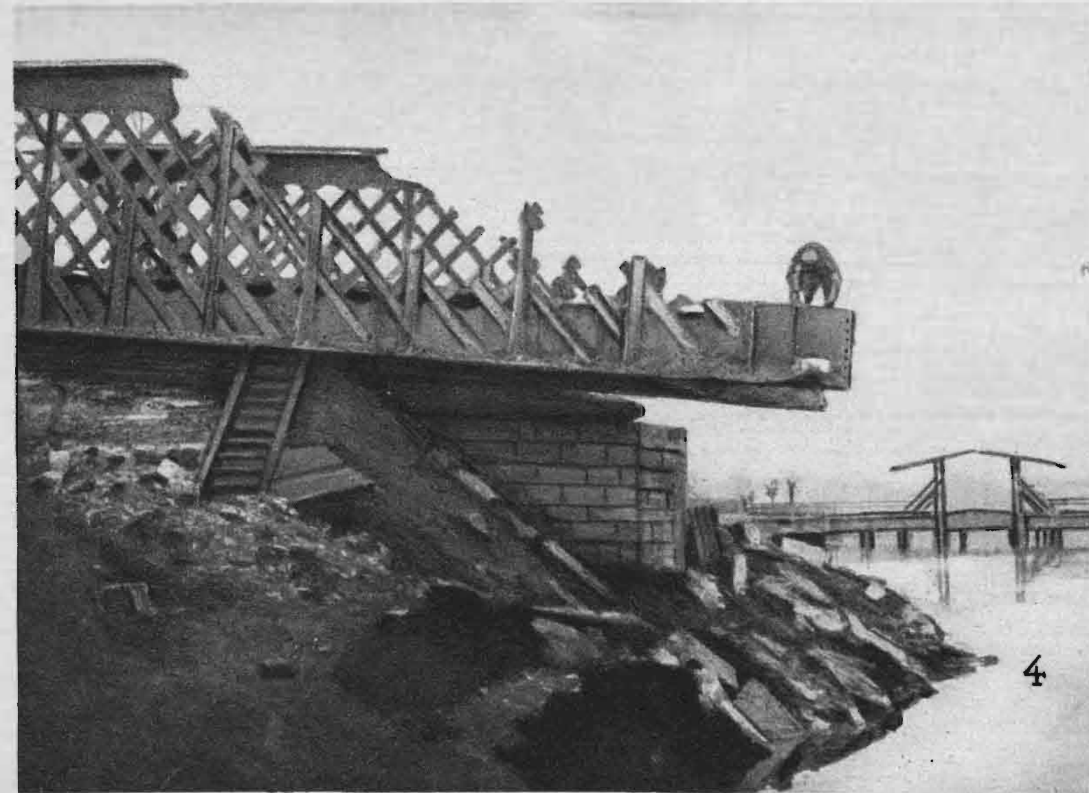
Reconstruction par les pionniers allemands d'un pont détruit par les Belges.
