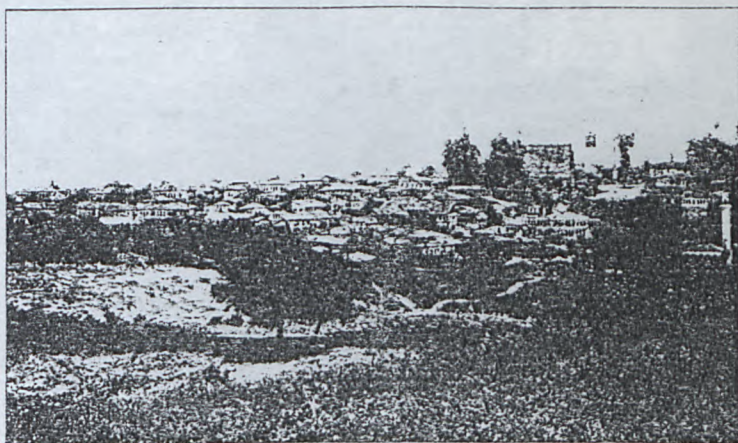
Edif. Rollet, Lyon
